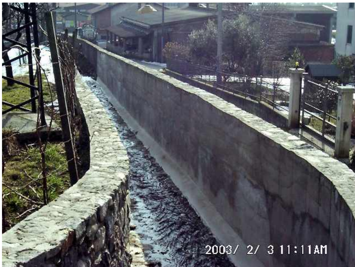
Foto n°2 Corso d'acqua A - Canalizzazione
