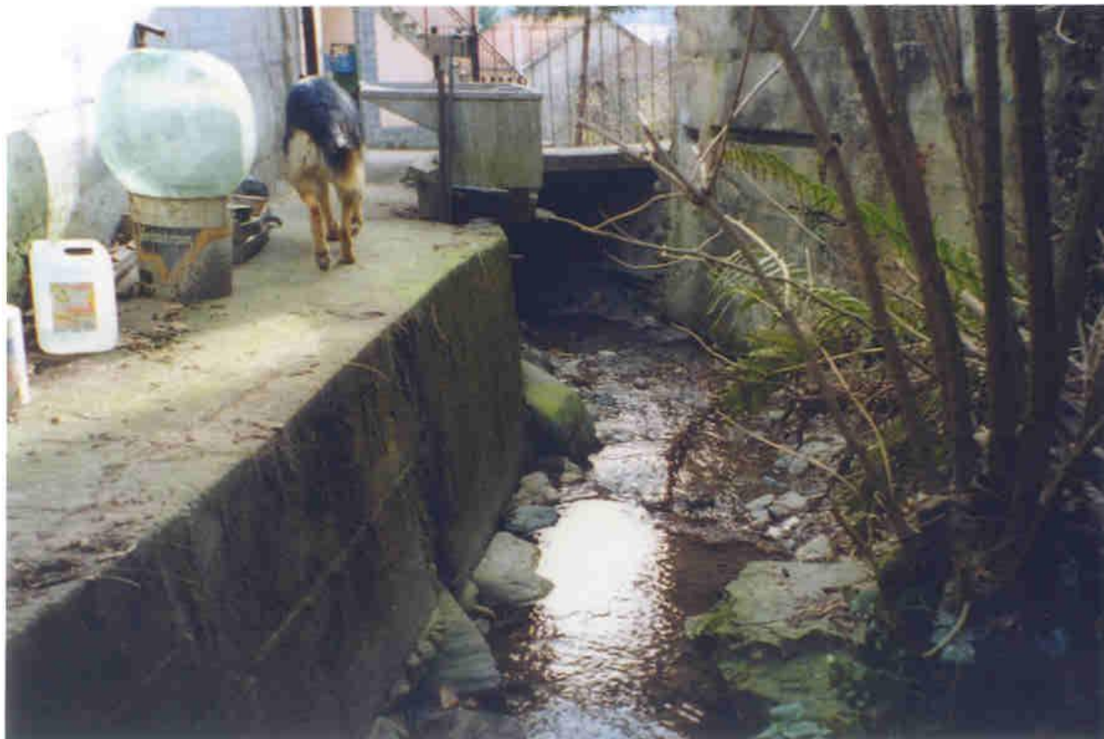
Foto n°4 Corso d'acqua C – Canalizzazione
