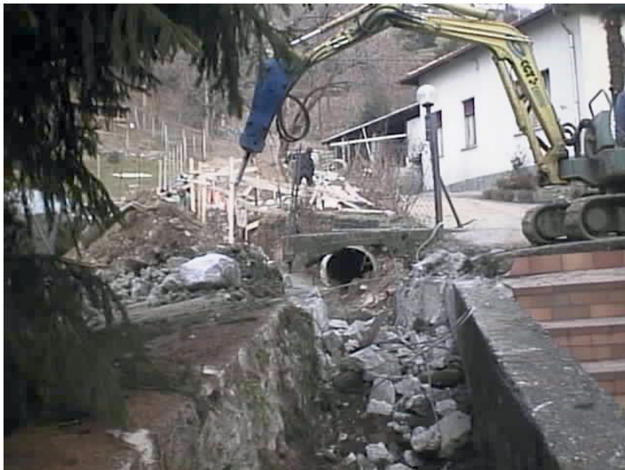
Foto n°5 Corso d'acqua C – Lavori di sistemazione della canalizzazione
