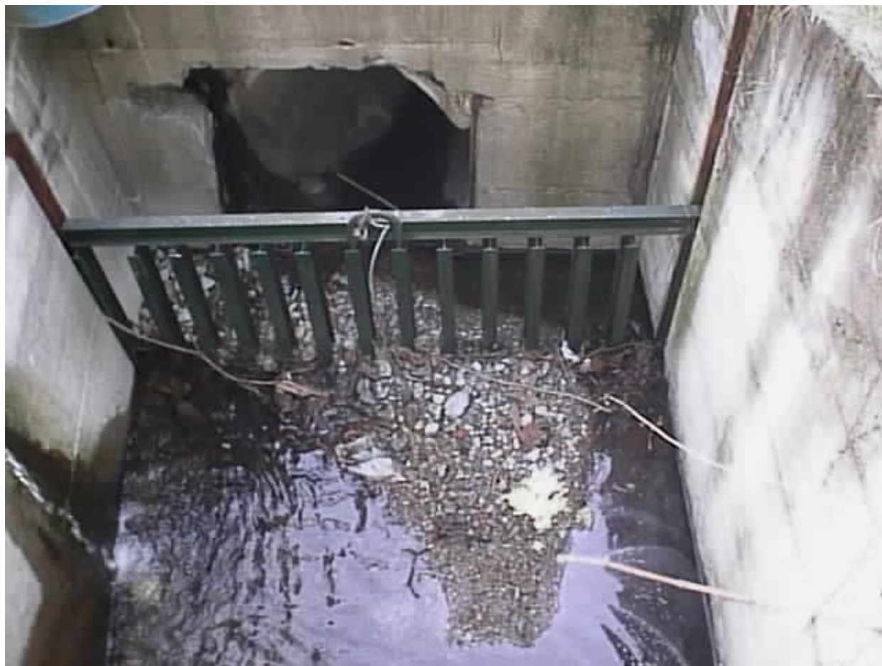
Foto n°3 Corso d'acqua B – Vasca di accumulo con griglia
