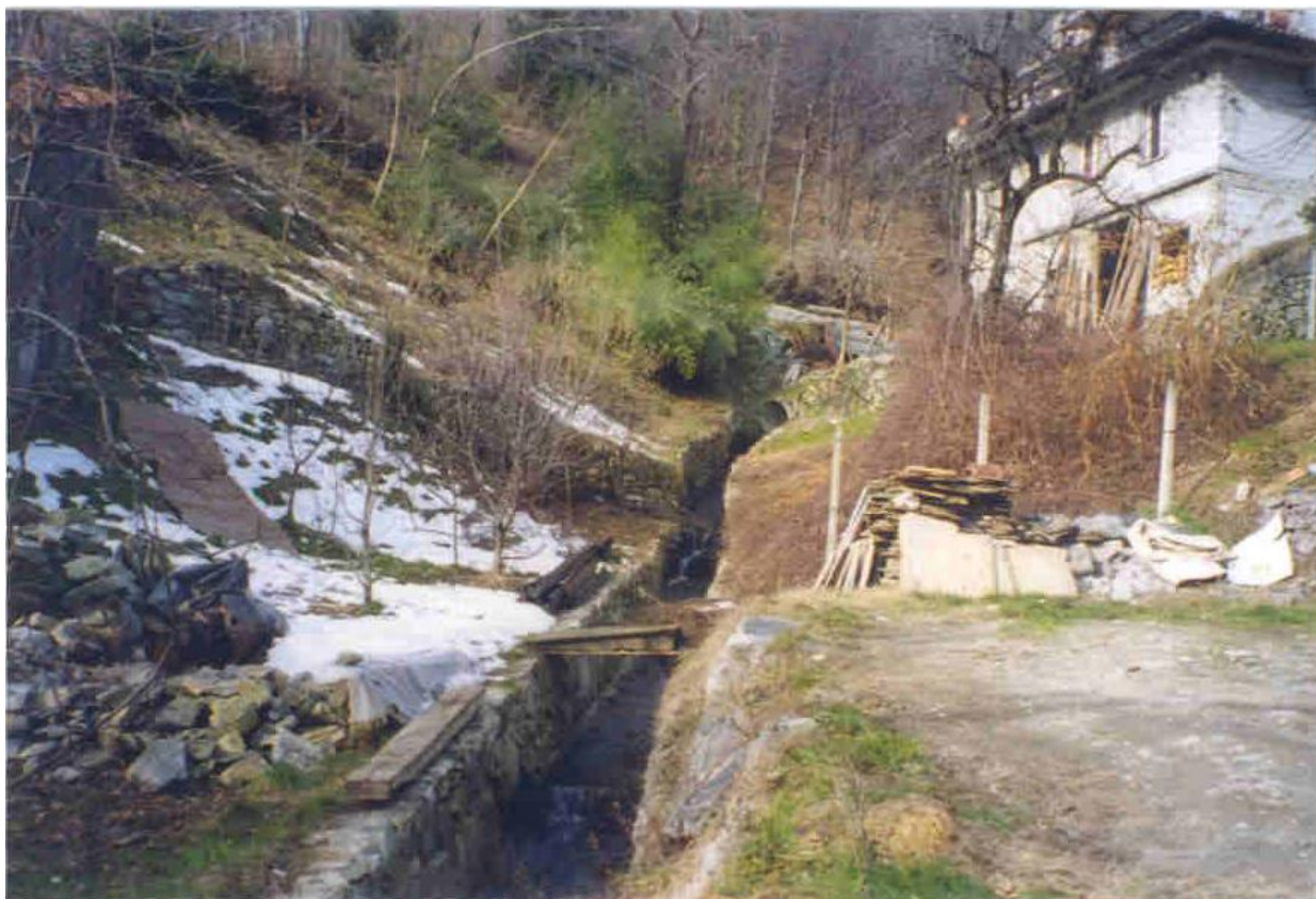
Foto n°8 Corso d'acqua E – Canalizzazione
