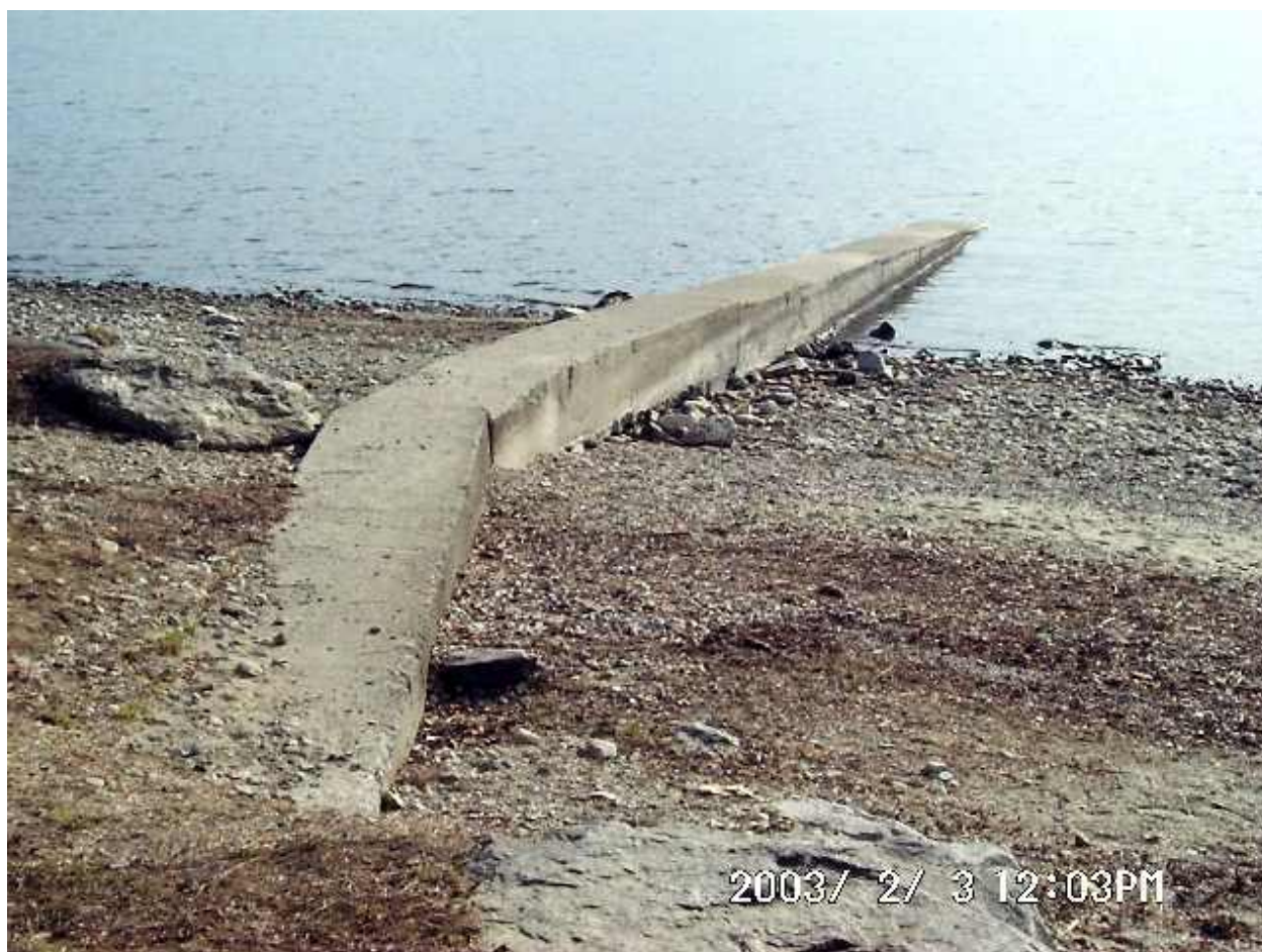
Foto n°6 Corso d'acqua C – Sbocco al lago
